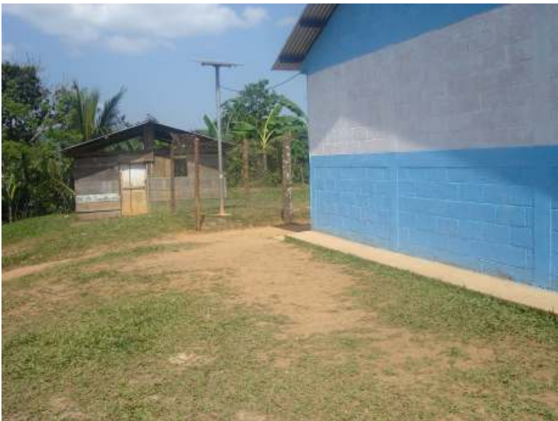
Fig. 2: Escuela de Primaria (edificio azul). Instalación en poste
