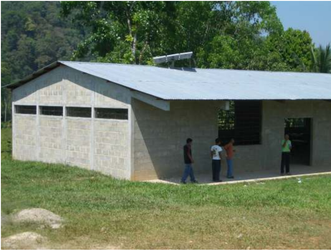
Fig.1ª: Complejo del Instituto Básico. Instalación en tejado del edificio grande
